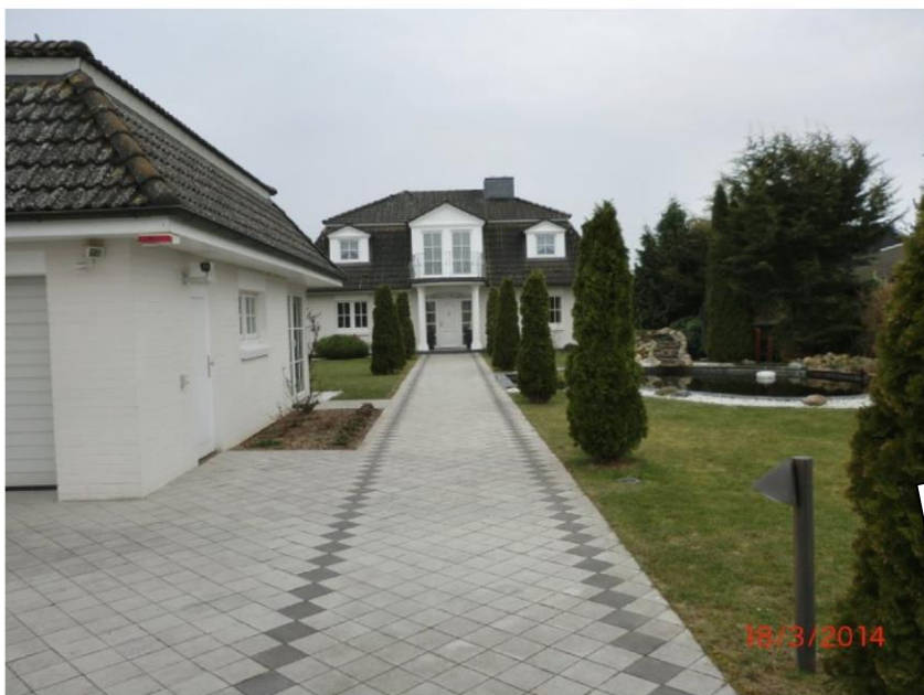
Güster - Villengrundstück mit direktem Seeeingang (im rückwärtigen Bereich)
